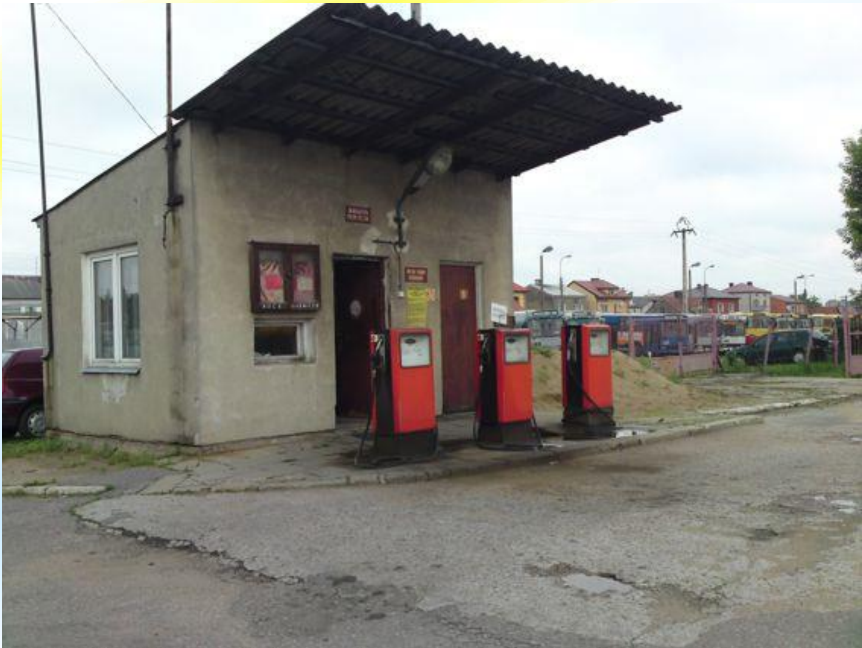
Stacja paliw przed modernizacją
